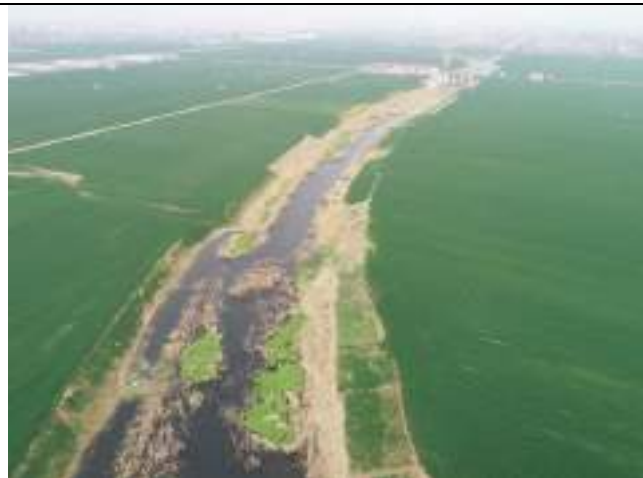
虬龙沟关庄闸附近河道现状—航拍图 1
