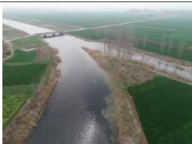
虬龙沟跨国道 310 段河道—航拍图 2
