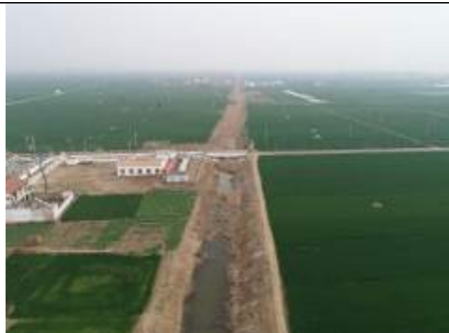
虬龙沟治理起点处河道现状—航拍图 1
