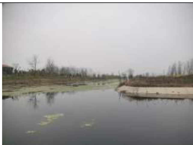
河道治理工程—现状
