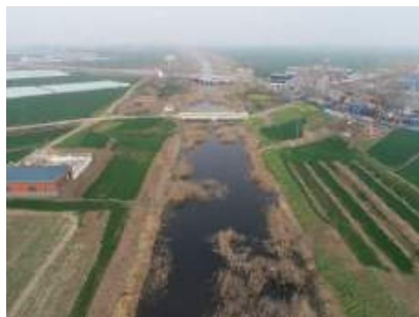
虬龙沟跨国道 310 段河道—航拍图 1
