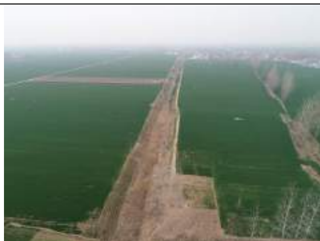
虬龙沟治理起点处河道现状—航拍图 3
