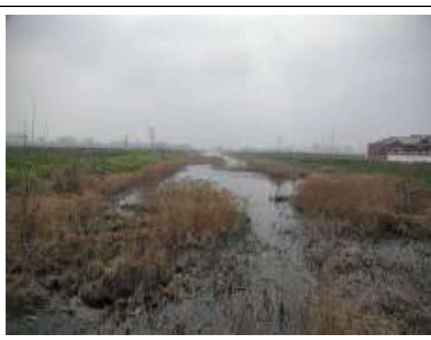
河道治理工程—现状
