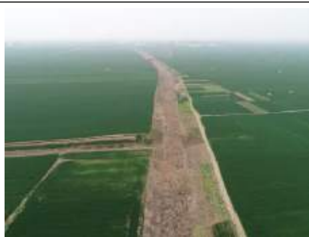
虬龙沟治理起点处河道现状—航拍图 2
