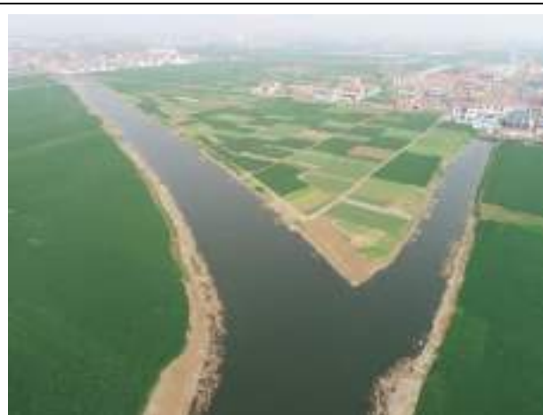
虬龙沟关庄闸附近河道现状—航拍图 2
