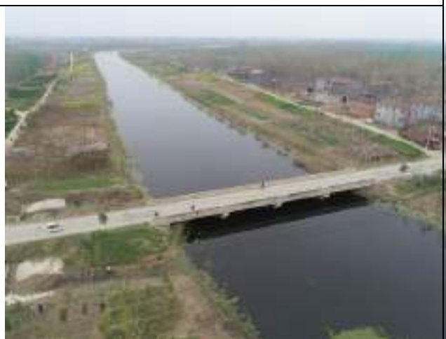
虬龙沟治理终点处河道现状—航拍图 1
