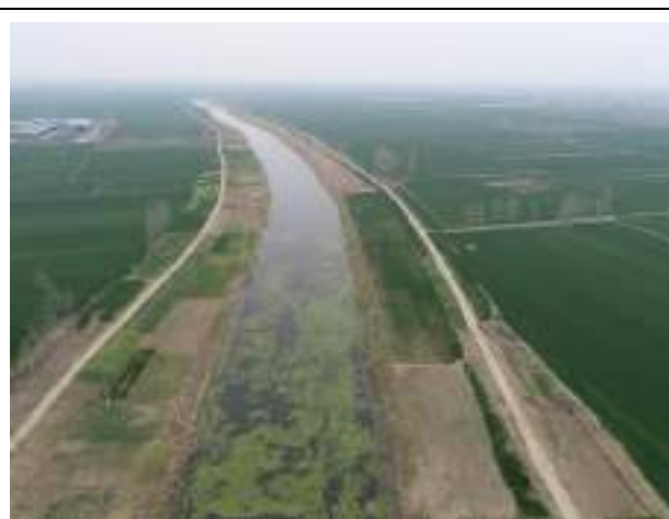
虬龙沟治理终点处河道现状—航拍图 3
