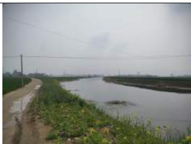
河道治理工程—现状
