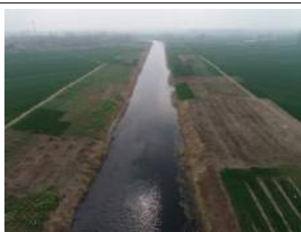
虬龙沟跨国道 310 段河道—航拍图 3
