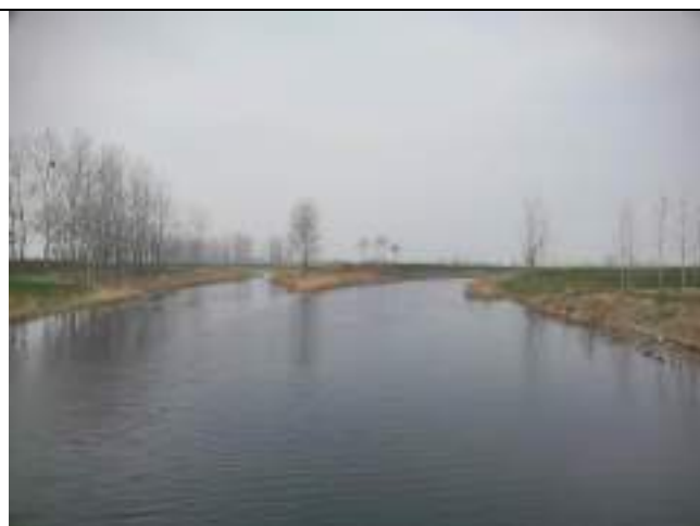
河道治理工程—现状
