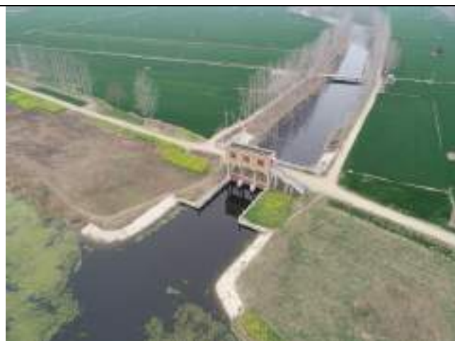
虬龙沟治理终点处河道现状—航拍图 2
