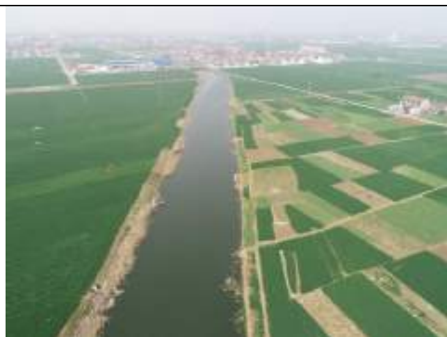
虬龙沟关庄闸附近河道现状—航拍图 3
