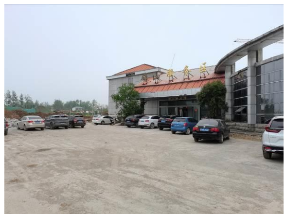
施工单位项目部利用服务区原有建筑
