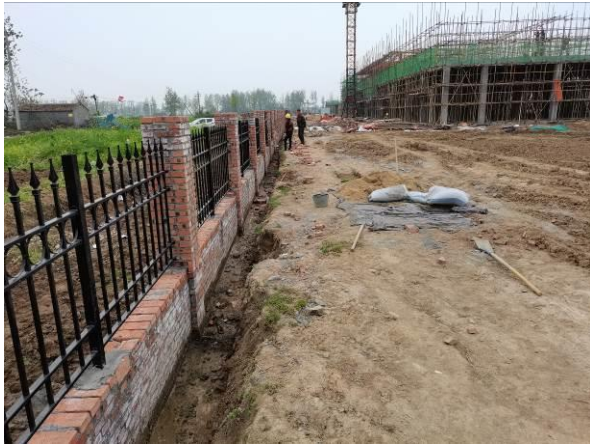
围栏及房建施工
