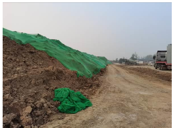
匝道区临时堆土覆盖
