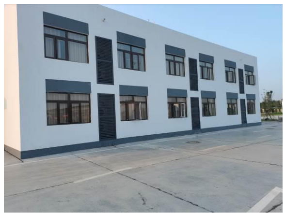
职工宿舍（施工生产生活区）
