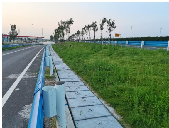
匝道边坡绿化及排水
