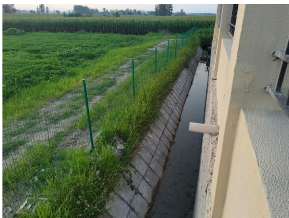
项目区服务场区四周排水
