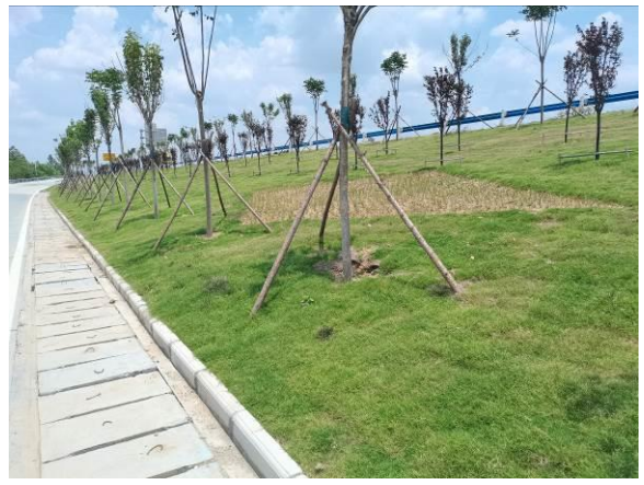
匝道边坡绿化及排水
