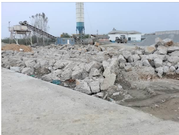
拆除建筑垃圾粉碎
