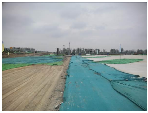
项目区广场硬化
