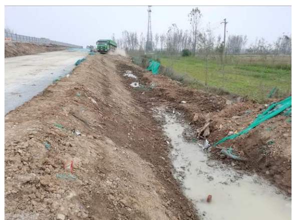
匝道区临时排水
