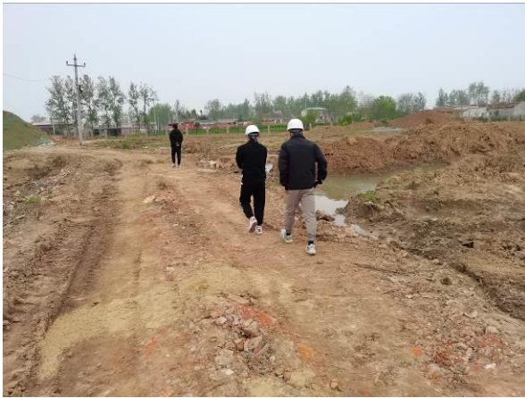
项目区内施工道路及临时排水
