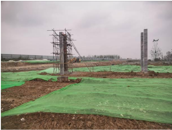
裸露地表临时覆盖
