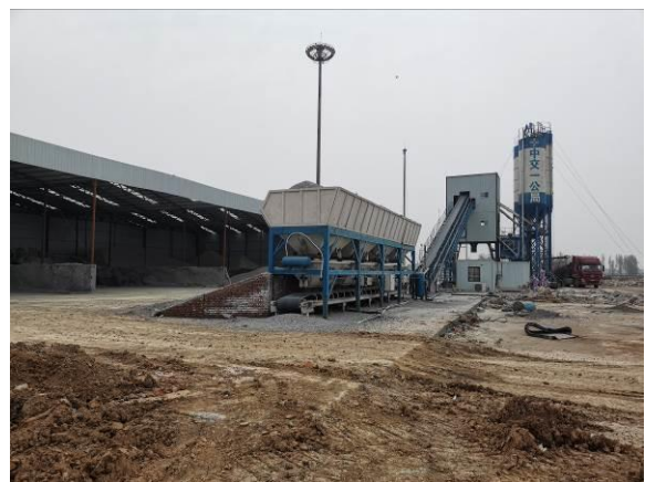
西服务场区内拌合站
