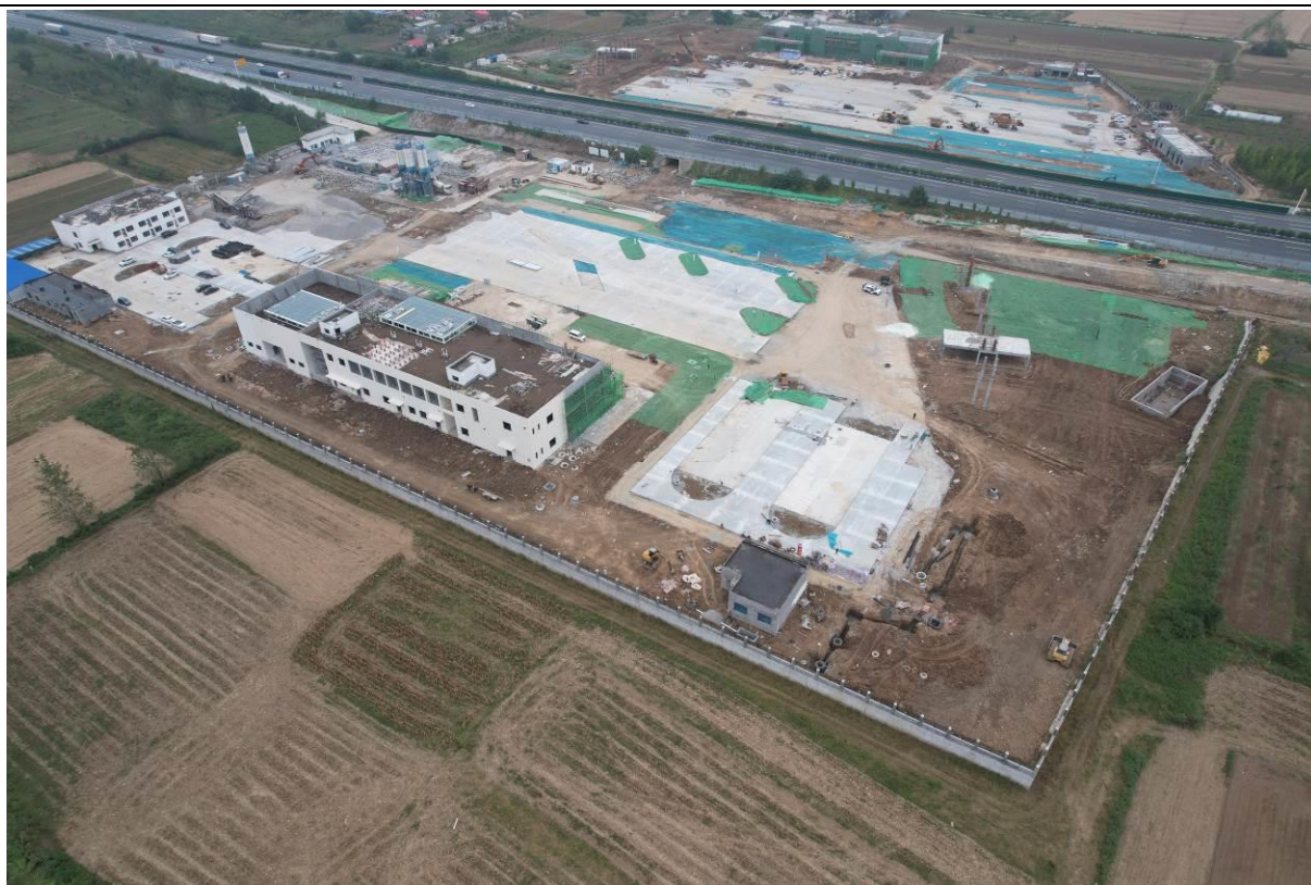
西服务场区施工现状
