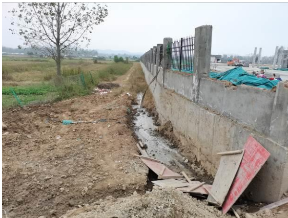
服务场区四周永临结合排水
