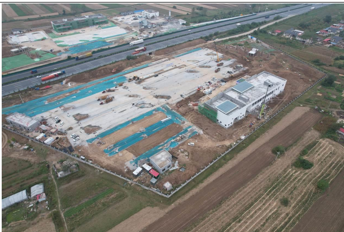
东服务场区施工现状
