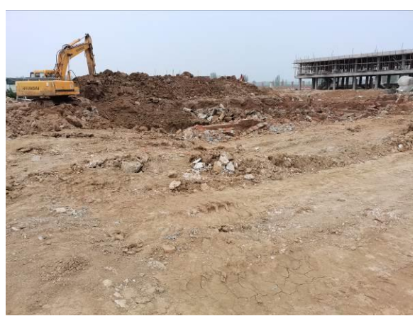
西服务场区建筑物基础拆除
