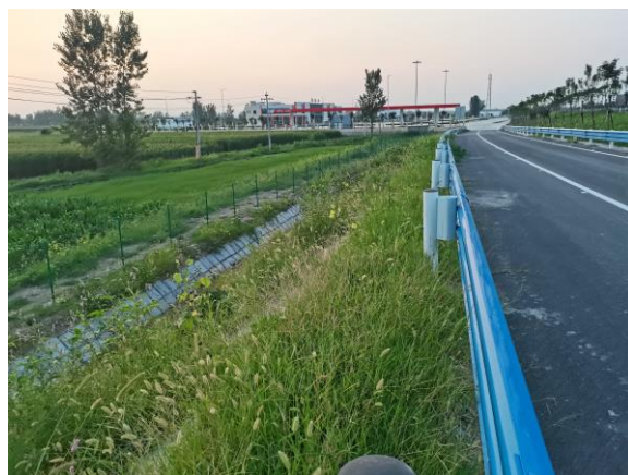
匝道边坡绿化及排水
