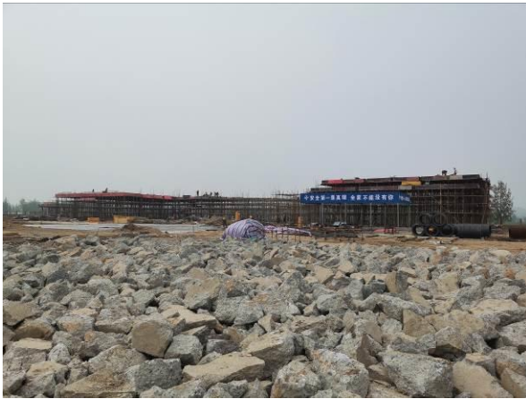
东服务场区原有广场拆除粉碎
