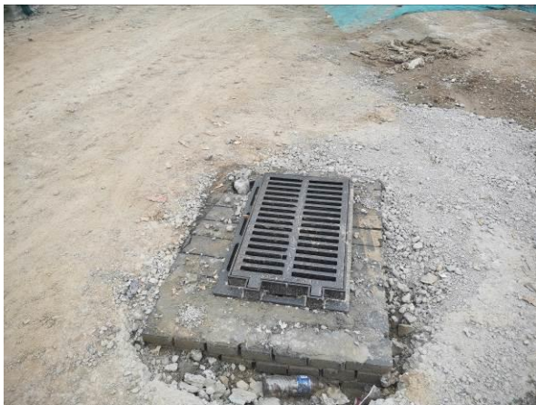
服务场区排水修筑
