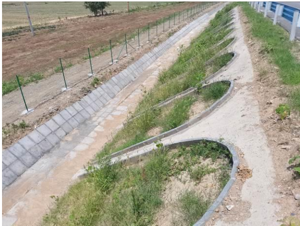
匝道边坡防护绿化及路基排水
