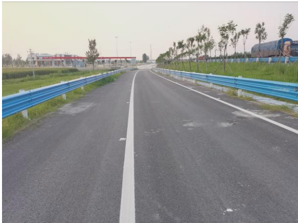
完工后的匝道
