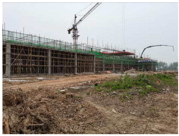
建筑物主体工程施工
