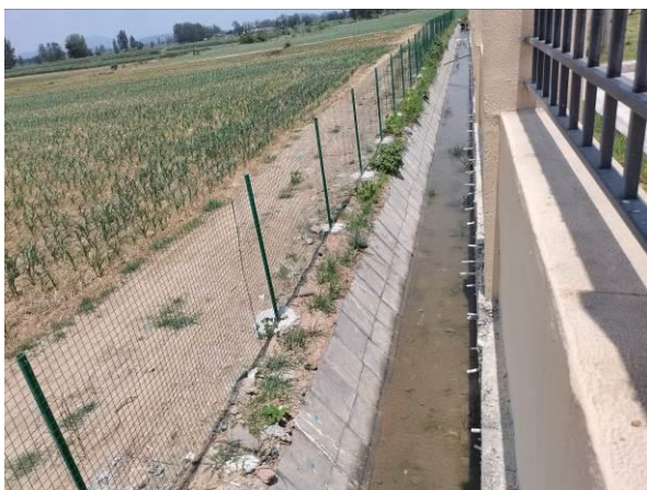
项目区四周排水
