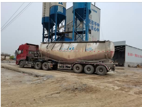
西服务场区内设置拌合站
