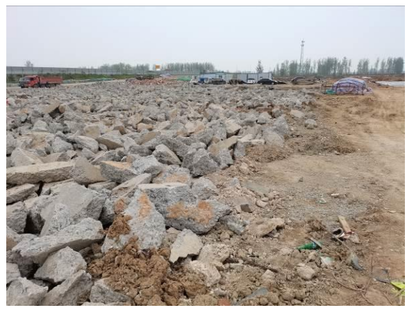
西服务场区原有广场拆除
