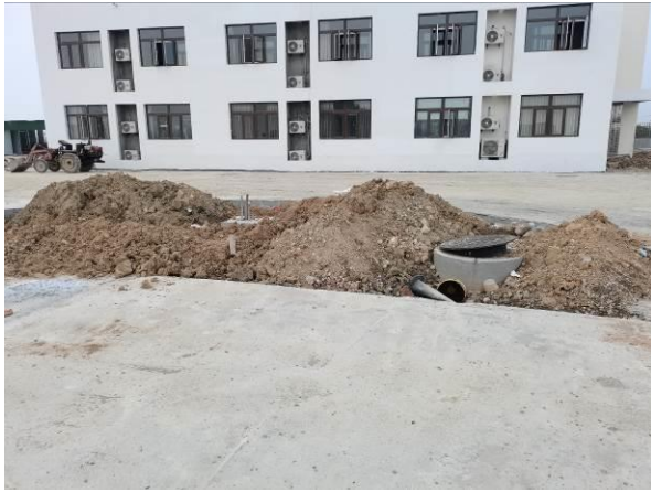
施工单位项目部利用已完工房建
