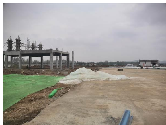
广场硬化及房建
