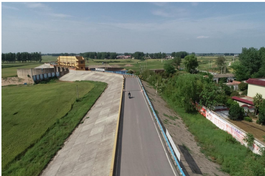
堤防工程竣工影像
