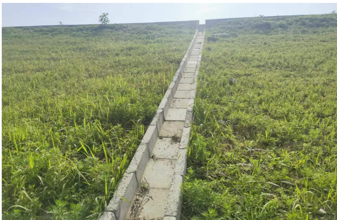
急流槽竣工影像
