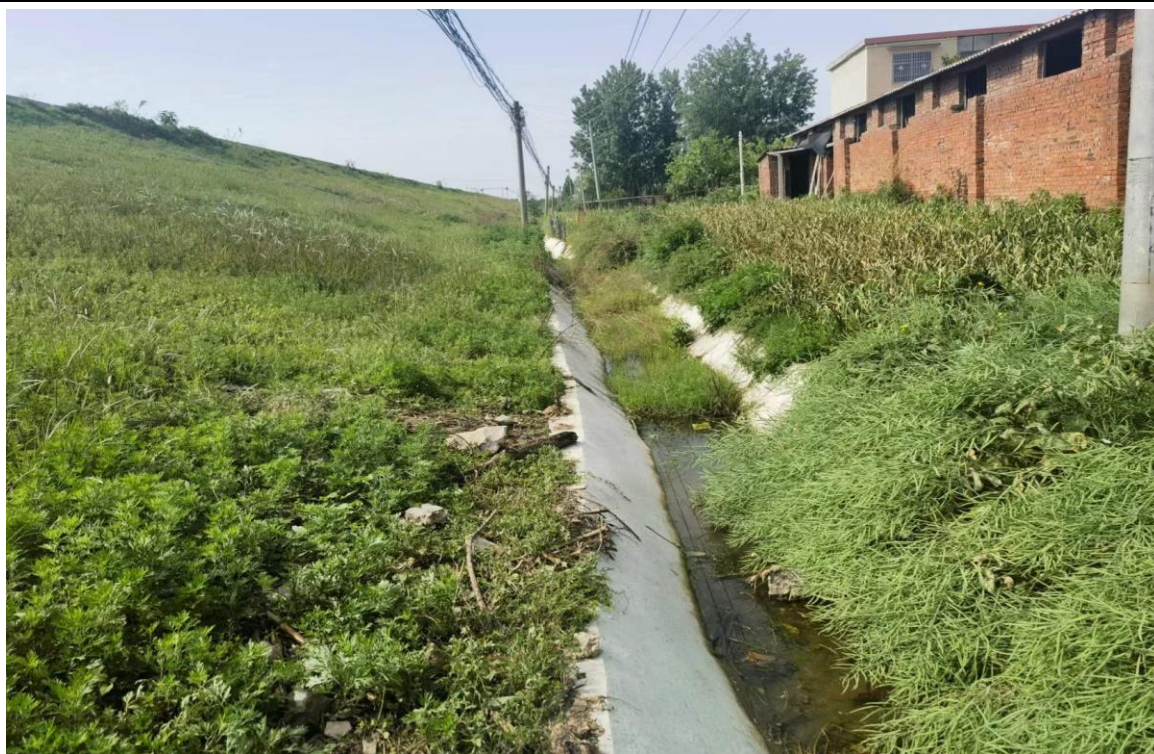
坡脚排水沟竣工影像
