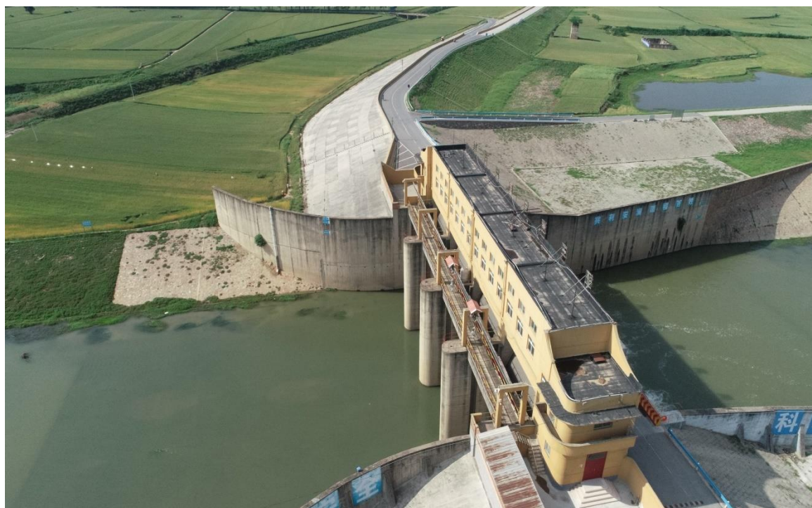
涵闸竣工影像
