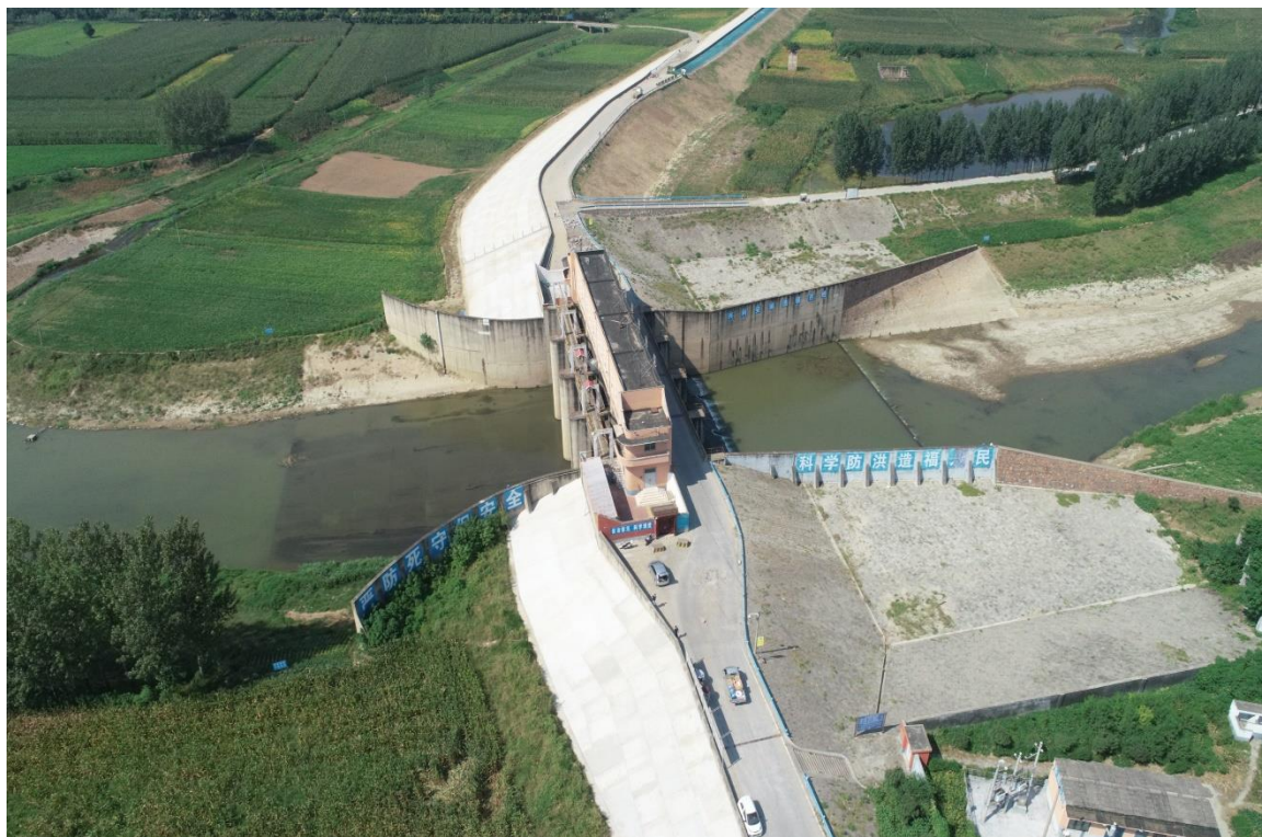
堤防工程竣工影像
