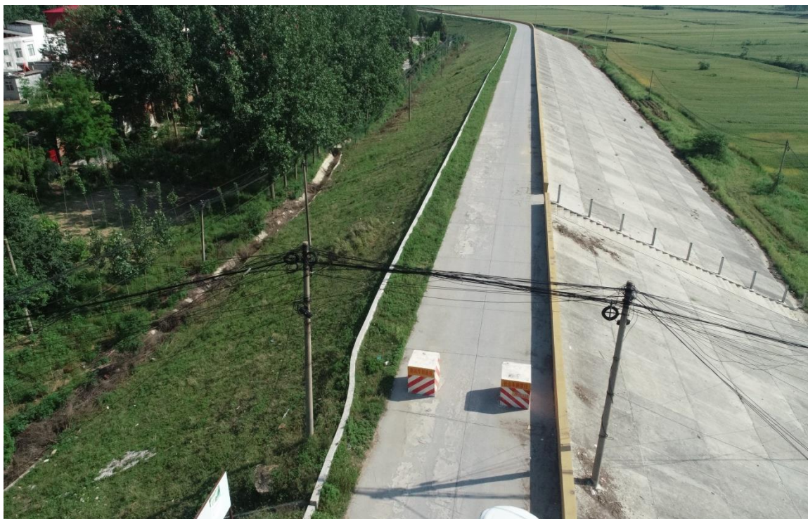
边坡绿化竣工影像
