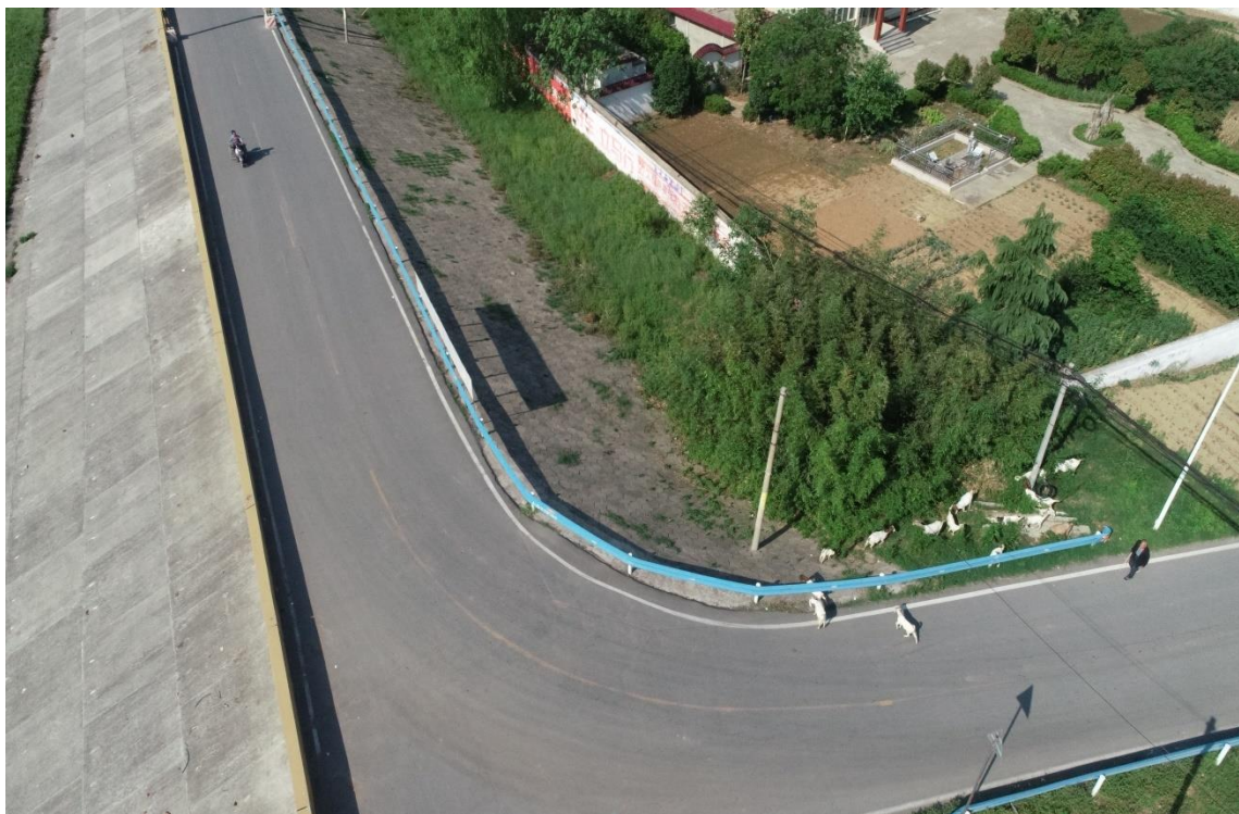
堤防工程竣工影像
