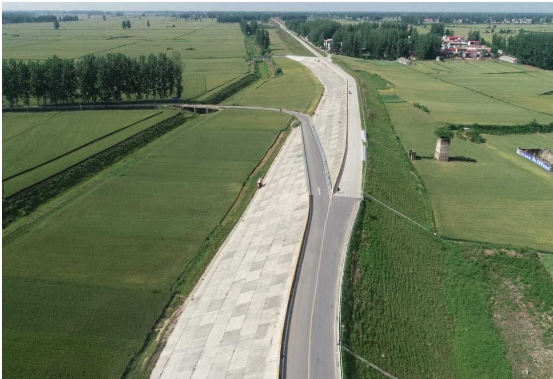
边坡绿化竣工影像
